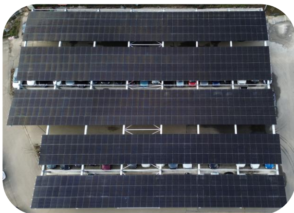
Abbildung 6: Mitarbeiterparkplatz in Bensheim von oben.
