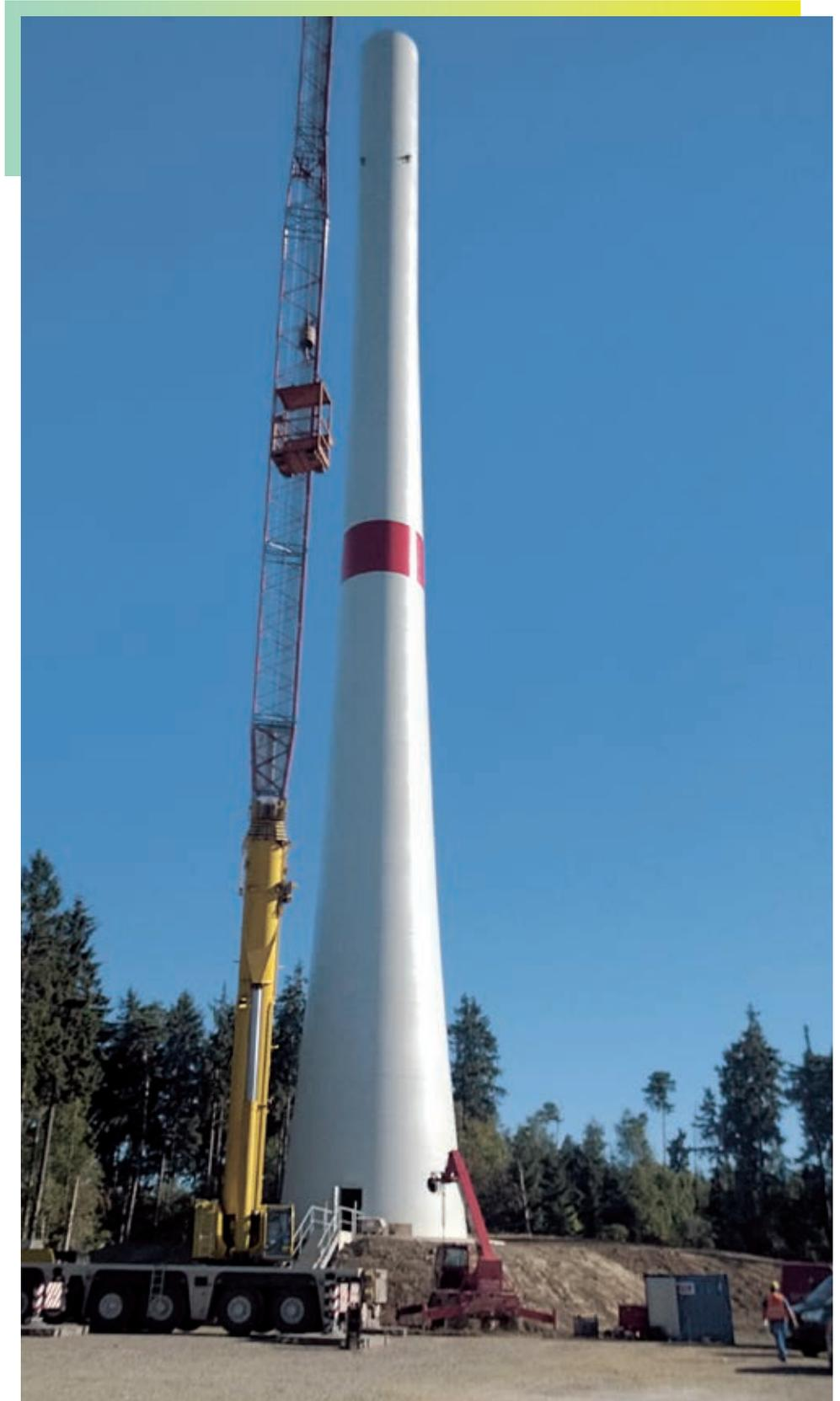
*Für die millimetergenaue Montage der Teilstücke beim Windpark Kalenborn kam ein gigantischer Mobilkran zum Einsatz.*
